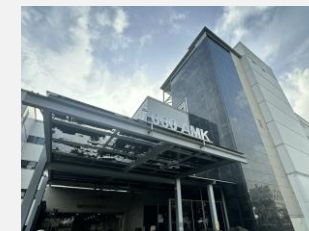
新加坡 研发、商务和运营中心
