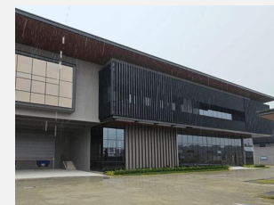
马来西亚，依斯干达公主城 运营中心 (建设中)
