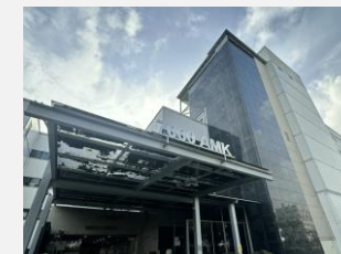
新加坡，宏茂桥 研发、商务和运营中心
