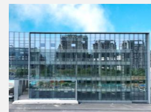
中国，合肥 研发中心、运营中心 (建设中)
