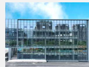
中国，合肥 研发中心、运营中心 (建设中)
