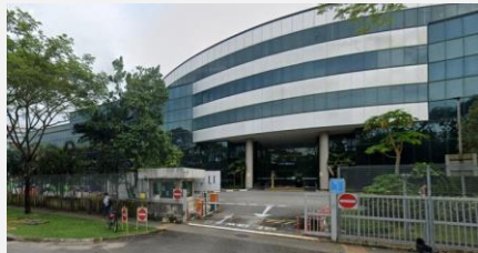
新加坡，宏茂桥 研发、商务和运营中心
